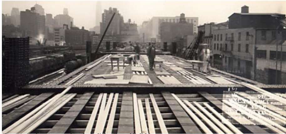
Construção da estrutura elevada da linha férrea High Line.
