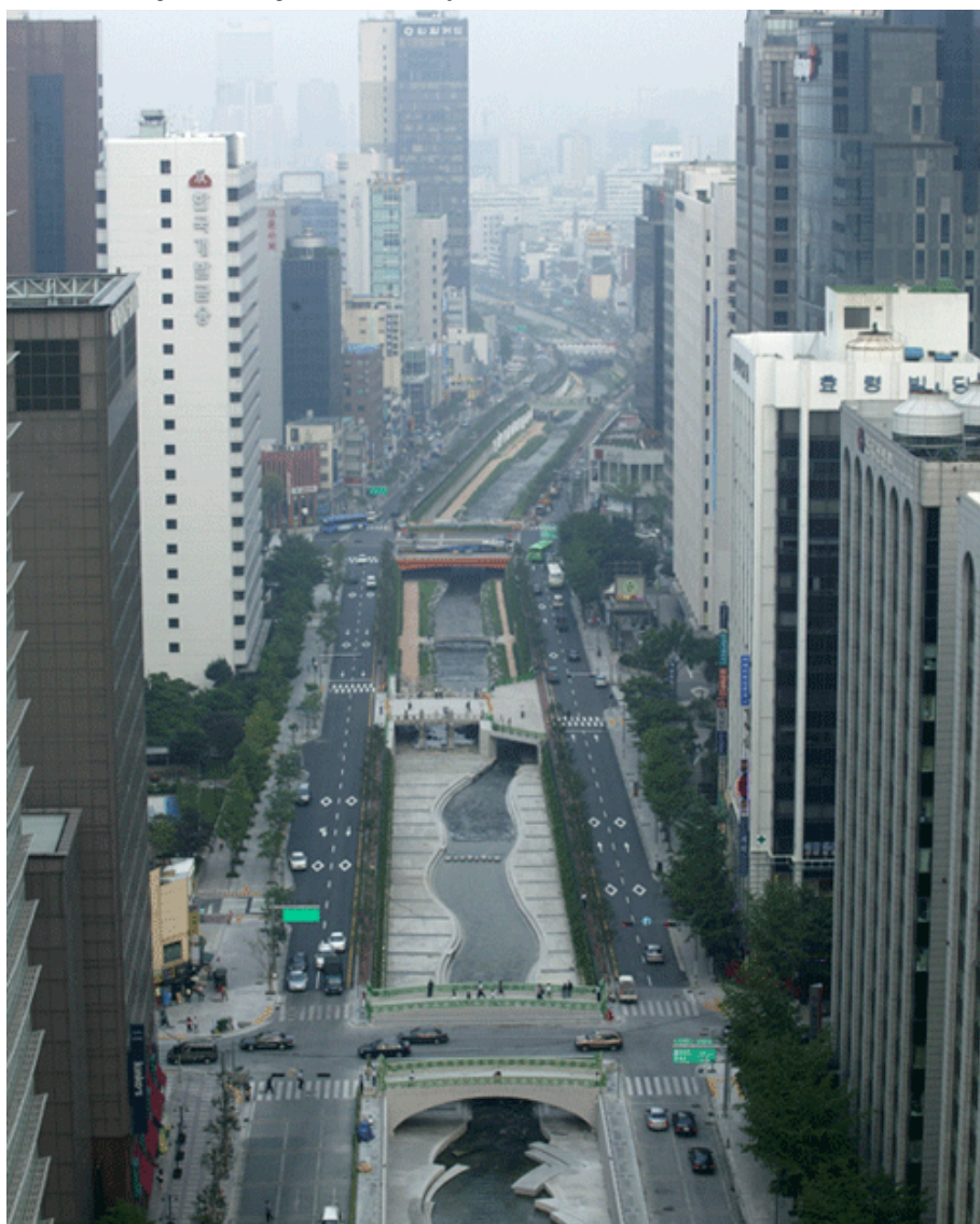
Cheonggyecheon após a demolição da autoestrada e plano de regeneração
