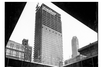
1954, edifício Seagram em construção. Fotografia de Phyllis Lambert 36
