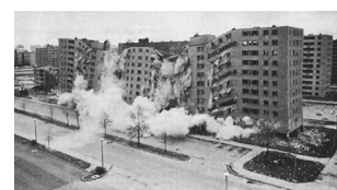
O projecto Pruitt Igoe foi das primeiras demolições de edifícios da arquitectura moderna por isso, a sua destruição foi descrita por Charles Jencks como o “dia em que morreu a arquitectura moderna”.
