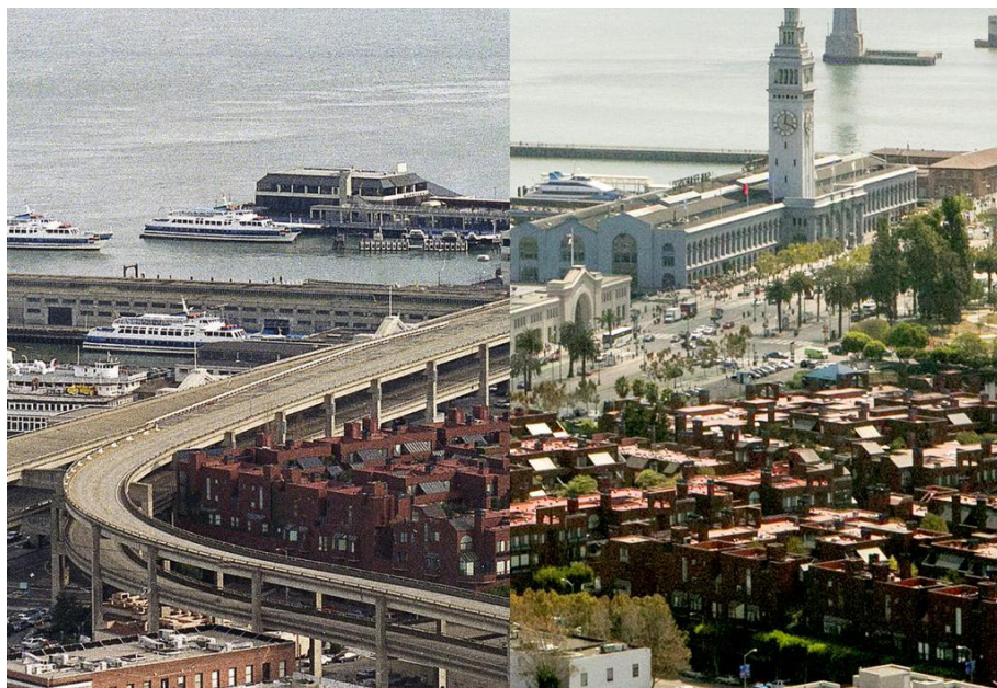
Embarcadero, antes e depois da intervenção
