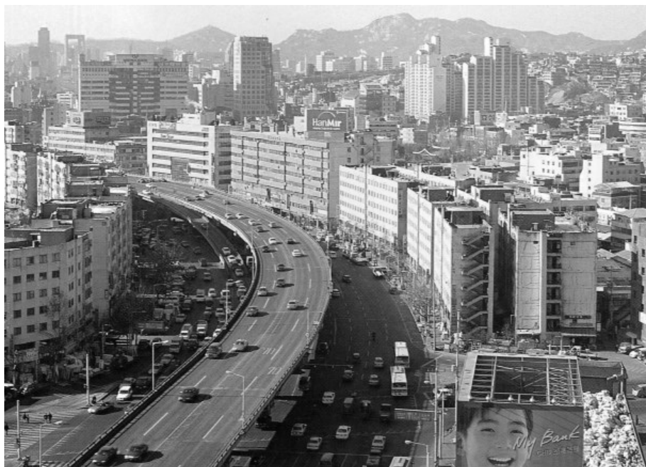
Autoestrada de quatro vias rápidas e dez vias adjacentes de trânsito lento
