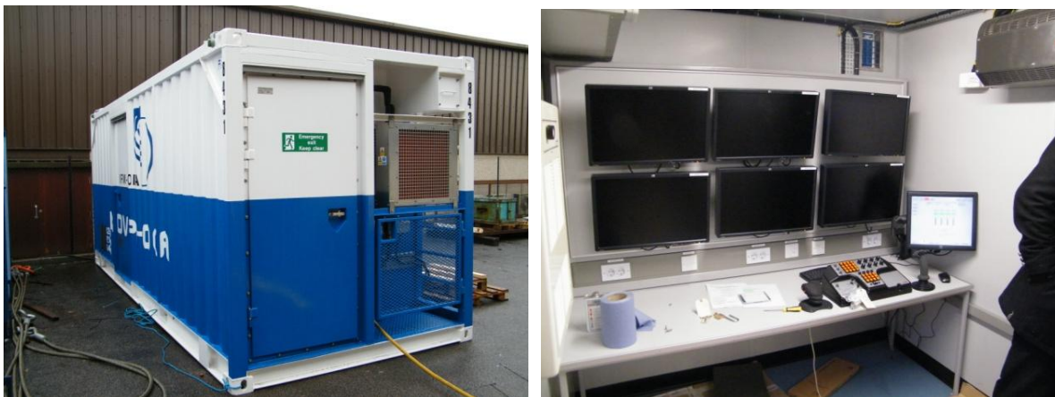
Abb. 16: links: der Steuercontainer; rechts: das Bedienpult mit Monitoren.
