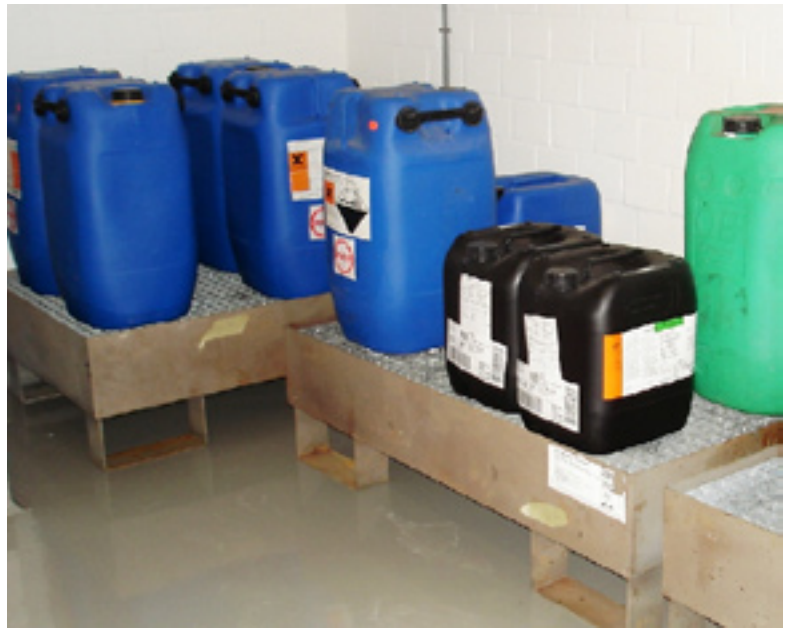
Wannen schützen das Grundwasser vor lagernden wasser-gefährdenden Stoffen. Verantwortung durch Eigenkontrollen (FOTO WALTHER V. LOEBENSTEIN)
