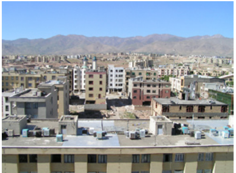
Blick auf „New Town Hashtgerd“. Die in der Wüste gelegene Stadt ist für 500 000 Einwohner konzipiert und wird zur Zeit erbaut. Sie soll der 70 Kilometer entfernten Hauptstadt Teheran als Entlastungsstadt dienen (FOTO SEELIG)
