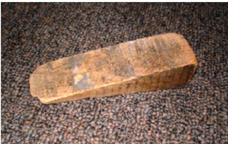
Das „Verkeilen“ von Brandschutz- und Rauchabschlusstüren erzeugt Gefahren und ist daher verboten (FOTO STOJENTHIN)
