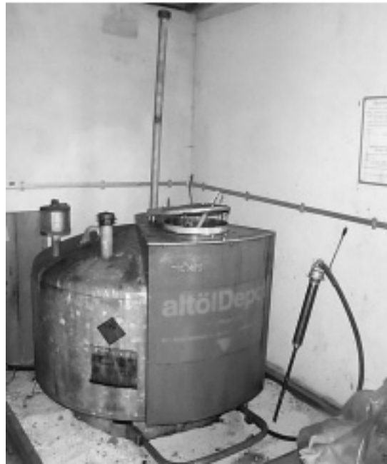
Altölbehälter wird durch einen Sachverständigen für Anlagen mit wassergefährdenden Stoffen überprüft
