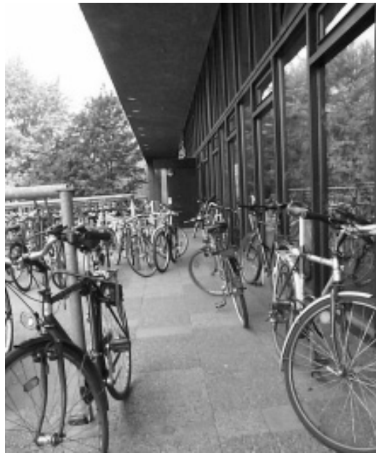
Radabstellanlagen sollen im Zuge der Gesamtkonzeption „Eingangsbereiche Straße des 17. Juni“ verbessert werden
