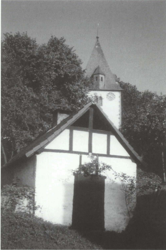
Abb.1 Obergässer Backhaus (I) (1832) am Pfarrgarten mit Kirche, Fachwerkfront nach Süden (Melchior)
