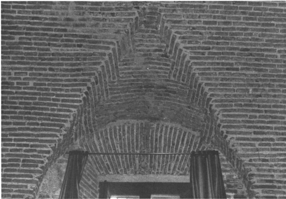
3. Detalle de la bóveda y ventana de la troje n.º 1.
