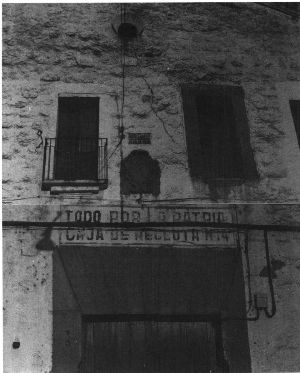
1. Alhóndiga de Plasencia. Detalle de la fachada.
