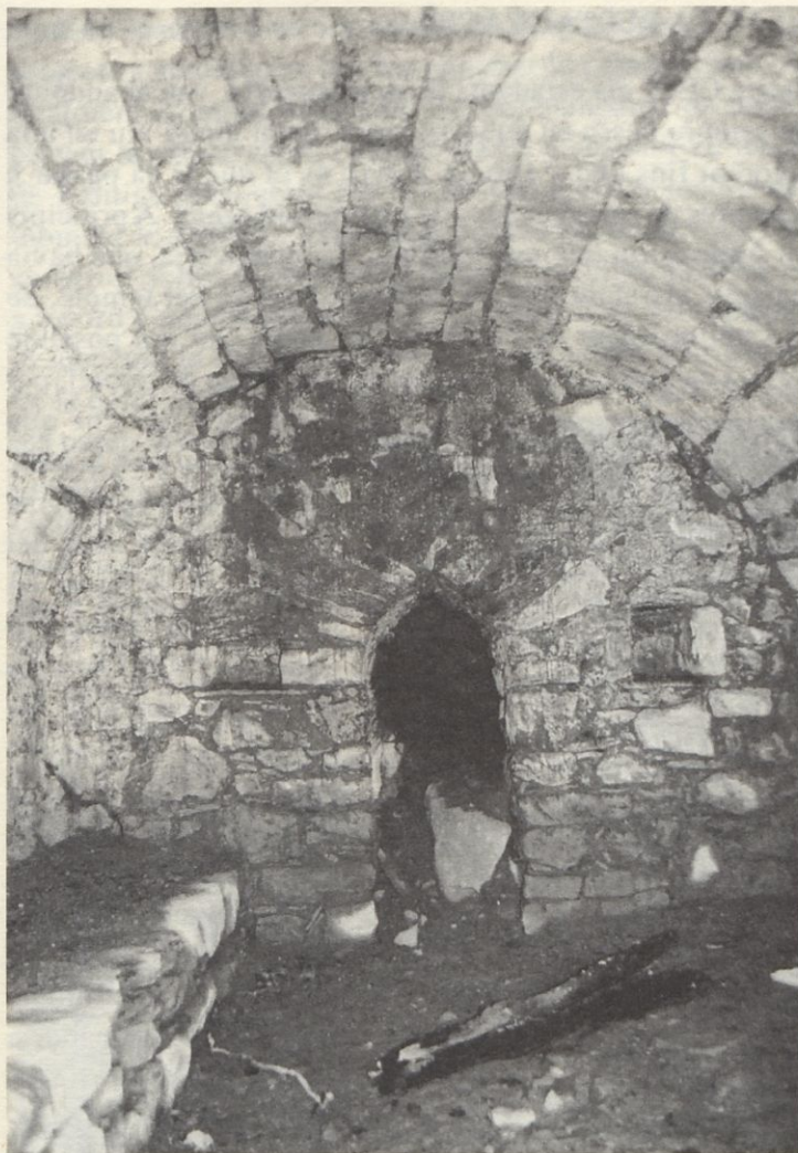
Sala trobada durant les obres de restauració.
