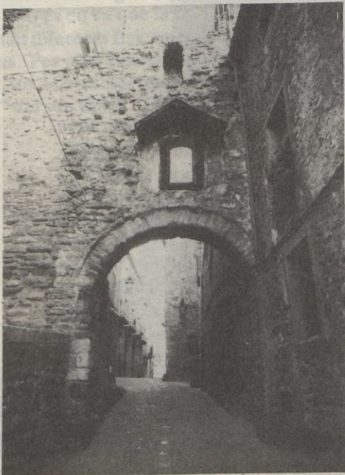
El portal del carrer de Tallaferro
