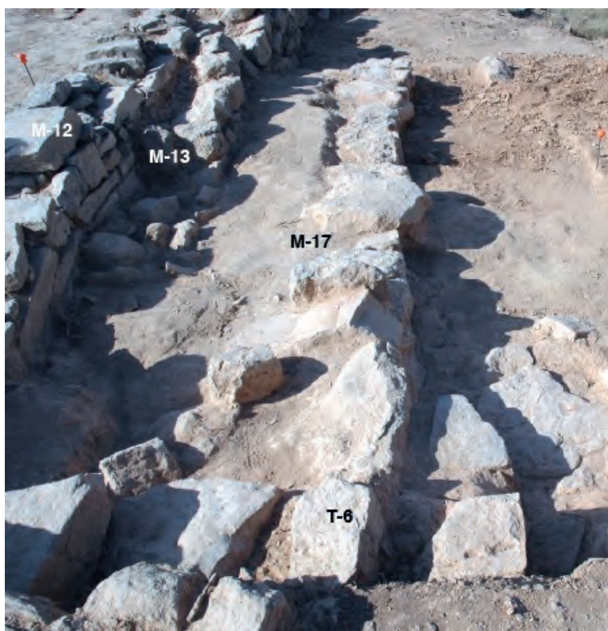
Figura 13. En primer terme, el parament sud de la torre T-6 i tot seguit, els tres murs adossats que formen la muralla oest.
