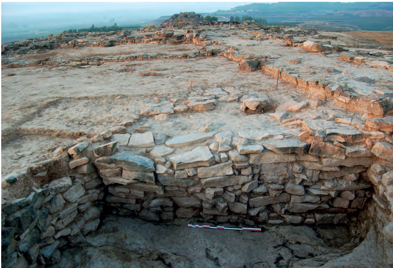
Figura 25. Refacció de la cisterna: detall del mur M-73, recolzant-se sobre el mur perimetral M-75. Vista des del nord.
