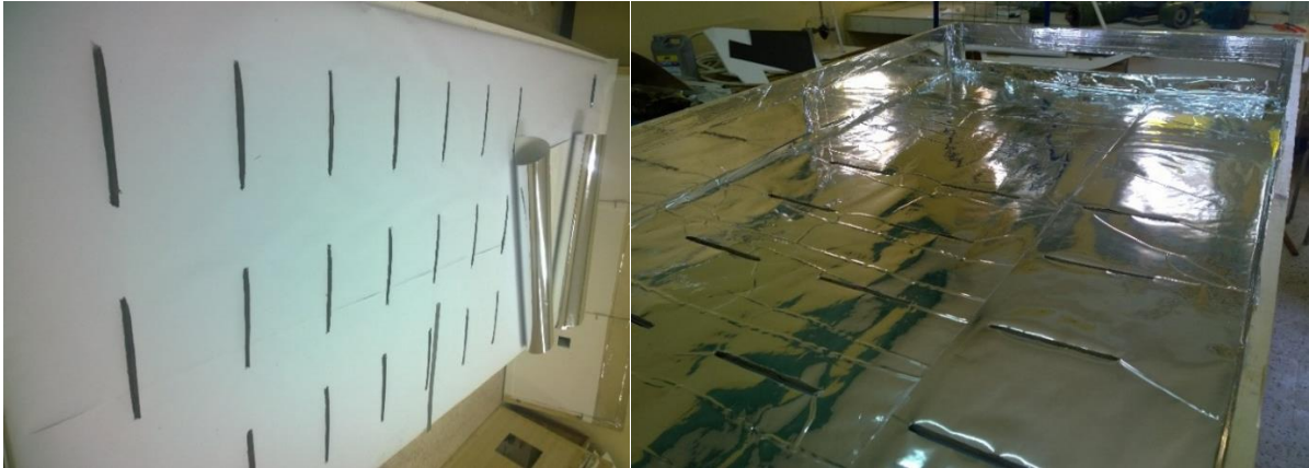
Figure 6.14 : Le revêtement de la face intérieure (en blanc) et la face extérieure (en aluminium) du faux plafond (Source : Auteur)
