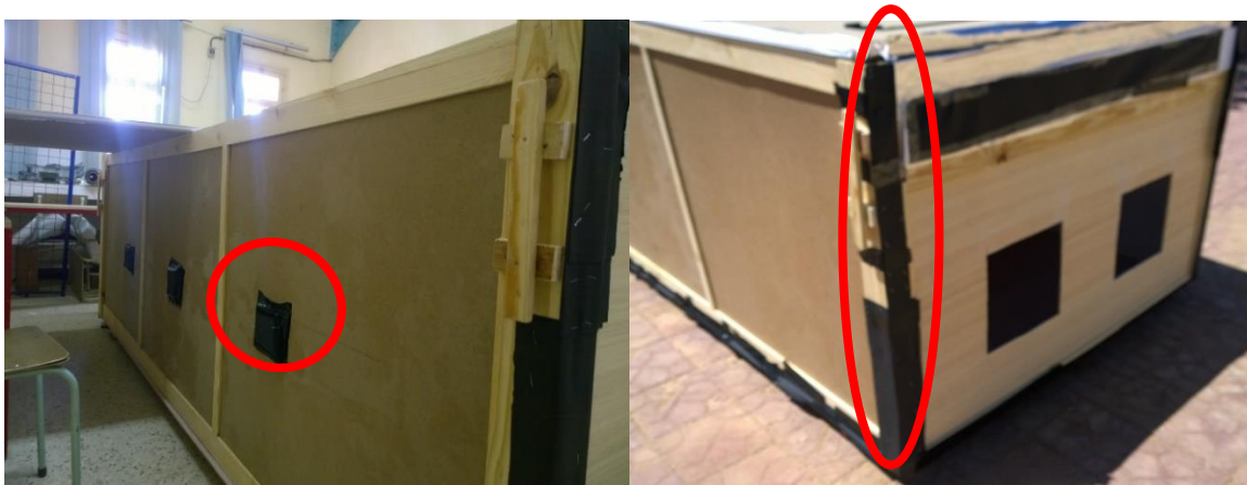
Figure 6.17 : A gauche, les trous de mesure ; A droite ; le traitement de la jonction entre les parois (Source : Auteur)
