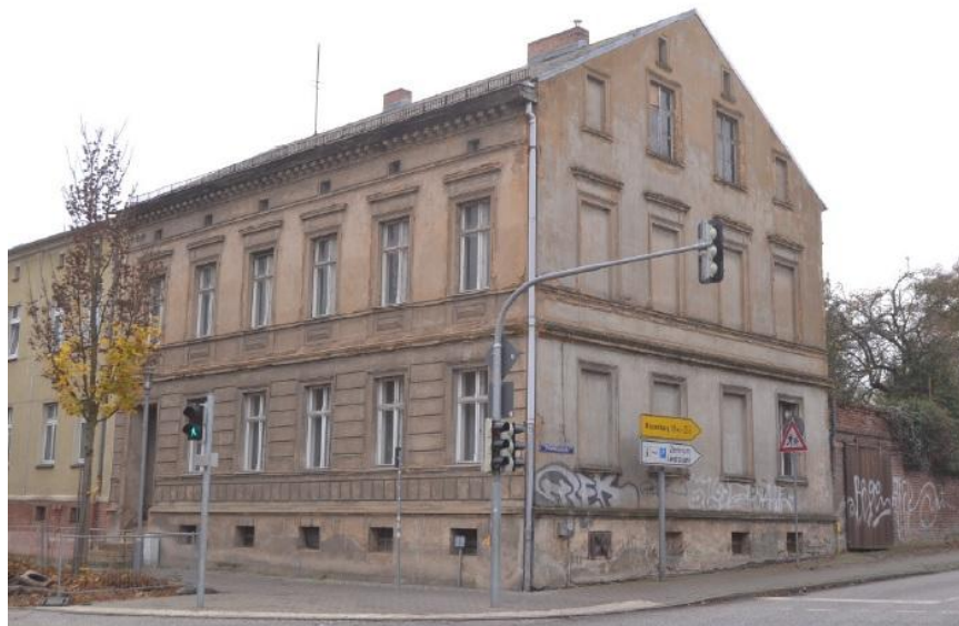
Abbildung 17: Sanierungsobjekt in Bad Belzig 89
