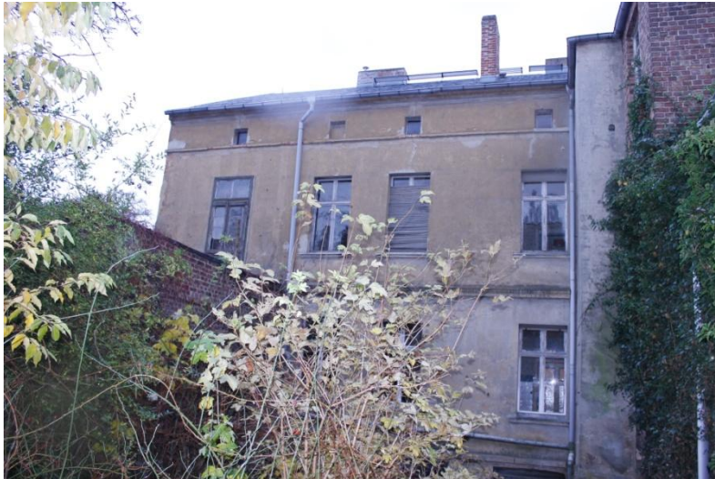
Abbildung 29: Hofseitige Sicht des Sanierungsobjektes 162
