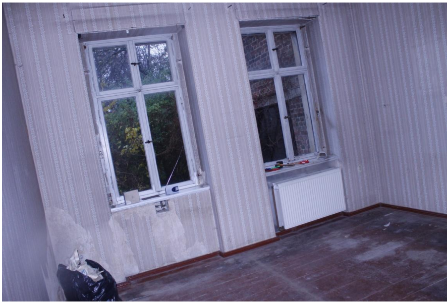
Abbildung 31: Fenster EG Ist-Zustand 164
