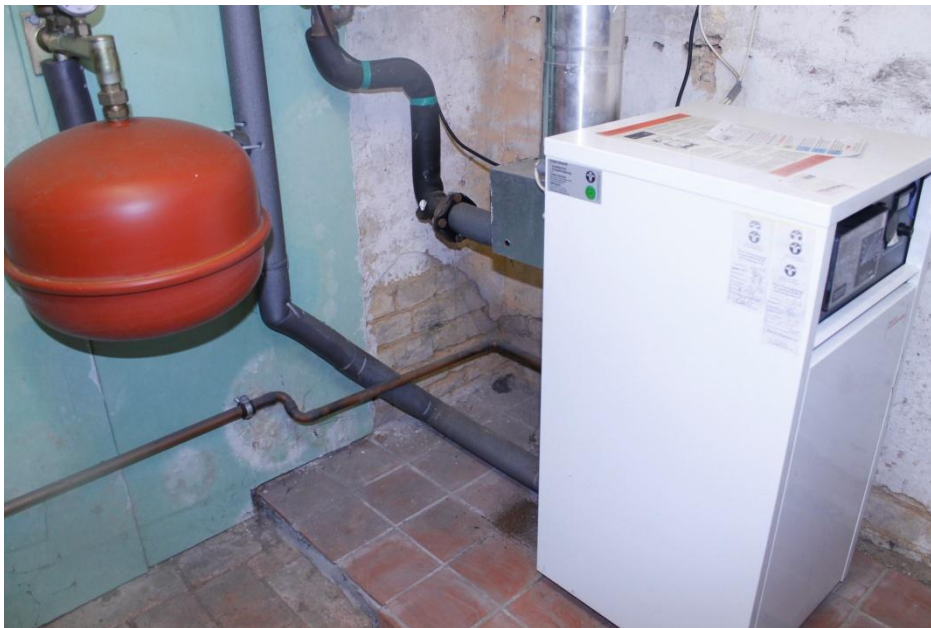
Abbildung 34: Veraltete Heizungsanlage 167
