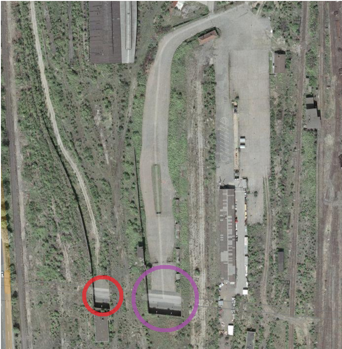
Abbildung 7: Übersicht über beide Rampen
