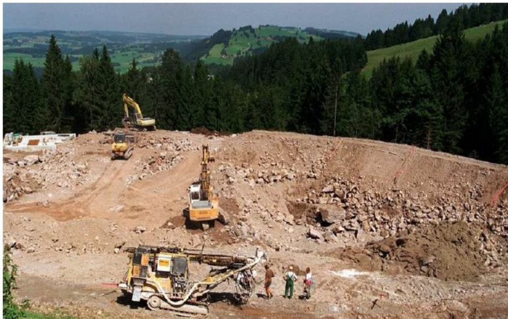
Abbildung 16: Bau eines Speicherbeckens. Foto von De Jong 2012
