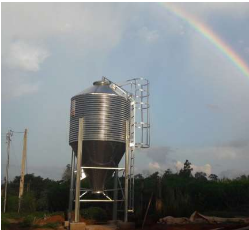
Imagem 5 – Silo para armazenagem de ração
