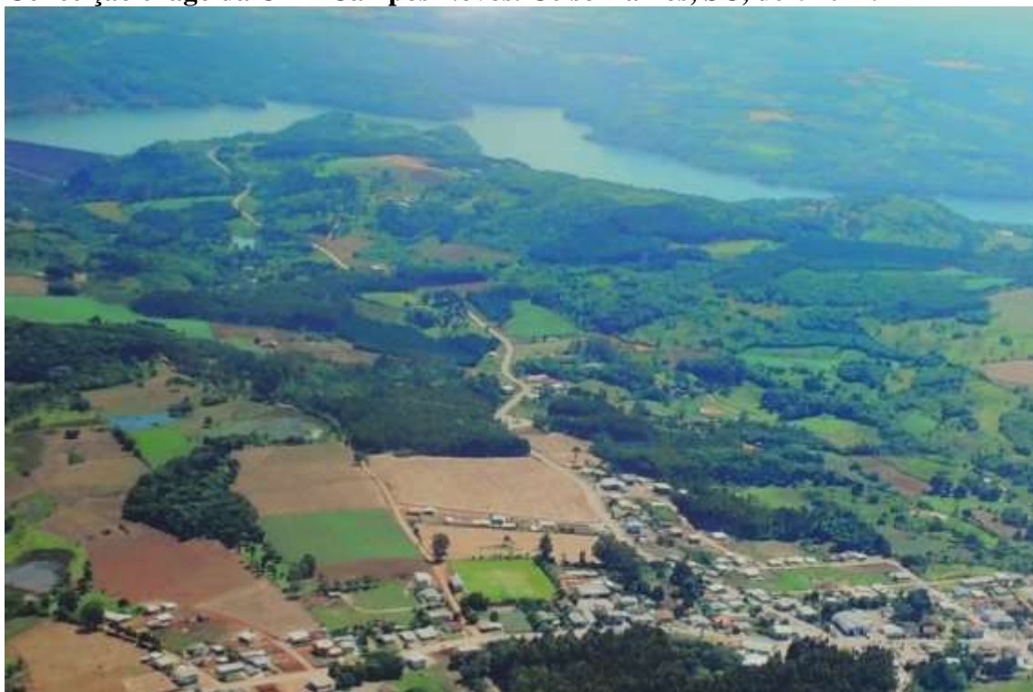
Figura 34 - Fotografia aérea com vista parcial da cidade, localidade de Imaculada Conceição e lago da UHE Campos Novos. Celso Ramos, SC, dez. 2011.
