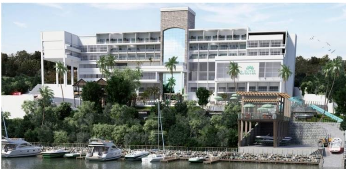
Figura 12: Projeto do Resort Termas Marina Itá, que está em construção
