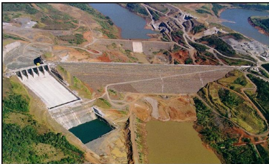
Figura 3: UHE Itá em fase de construção
