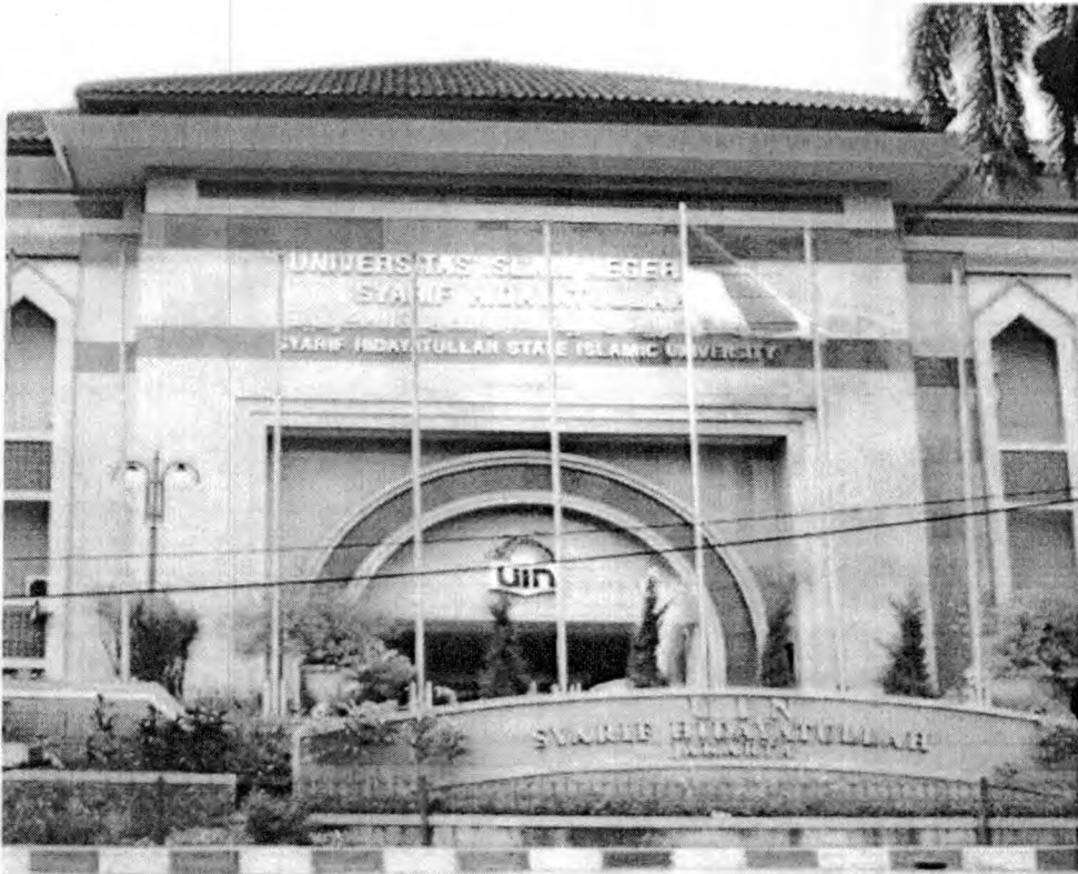
Gambar 3.2 Gedung UIN Syarif Hidayatullah Jakarta 43
