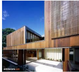
Gambar 3.3 Penerapan shading pada eksterior bangunan
