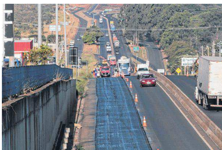
Foto 1 – Uberlândia-MG: Trecho Urbano da BR-050 em obras (2014)
