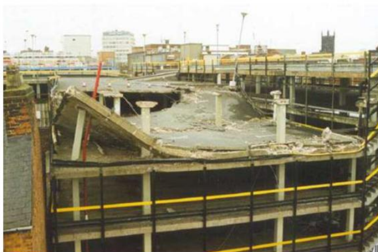
Figura 6 – Colapso parcial do edifício Pipers Row Car Park em Wolverhampton, Inglaterra em 1997
