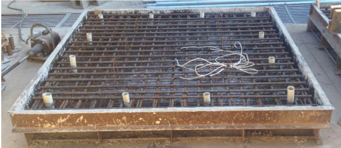
Figura 32 – Malha posicionada na forma metálicas.
