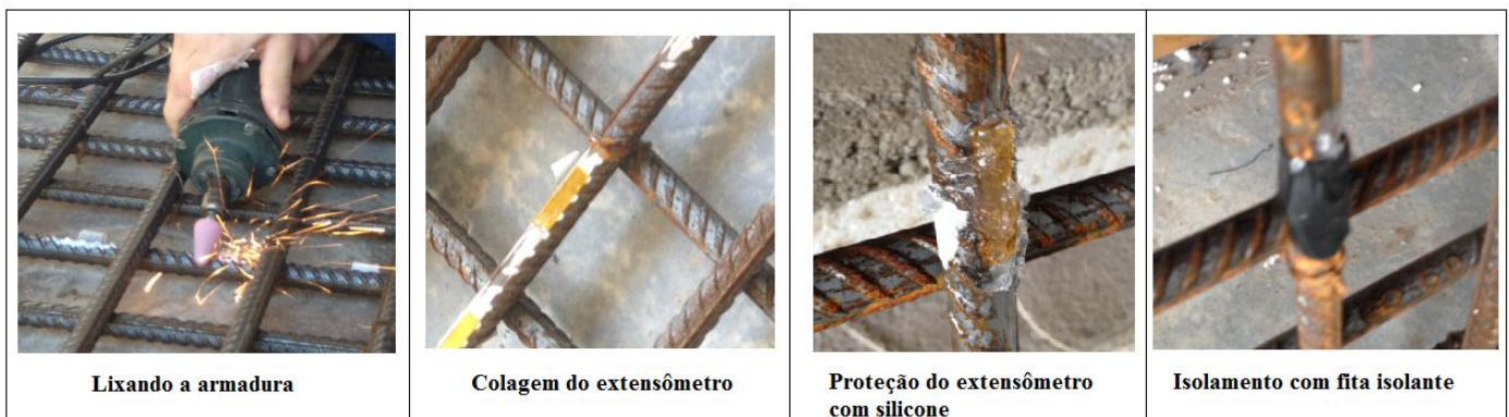
Figura 39 – Processo de fixação do extensômetro na armadura de flexão
