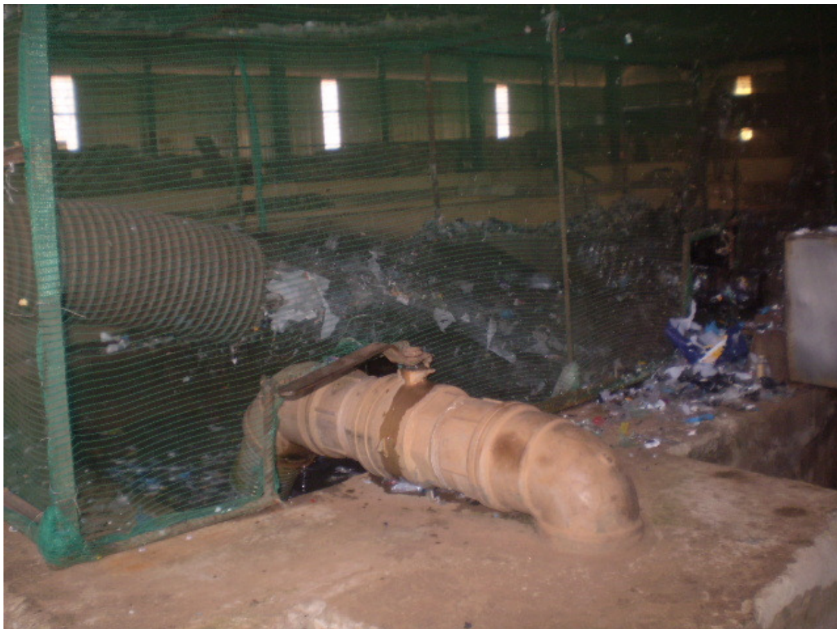
Figura 7: Tanque para lavagem de material reciclável.
