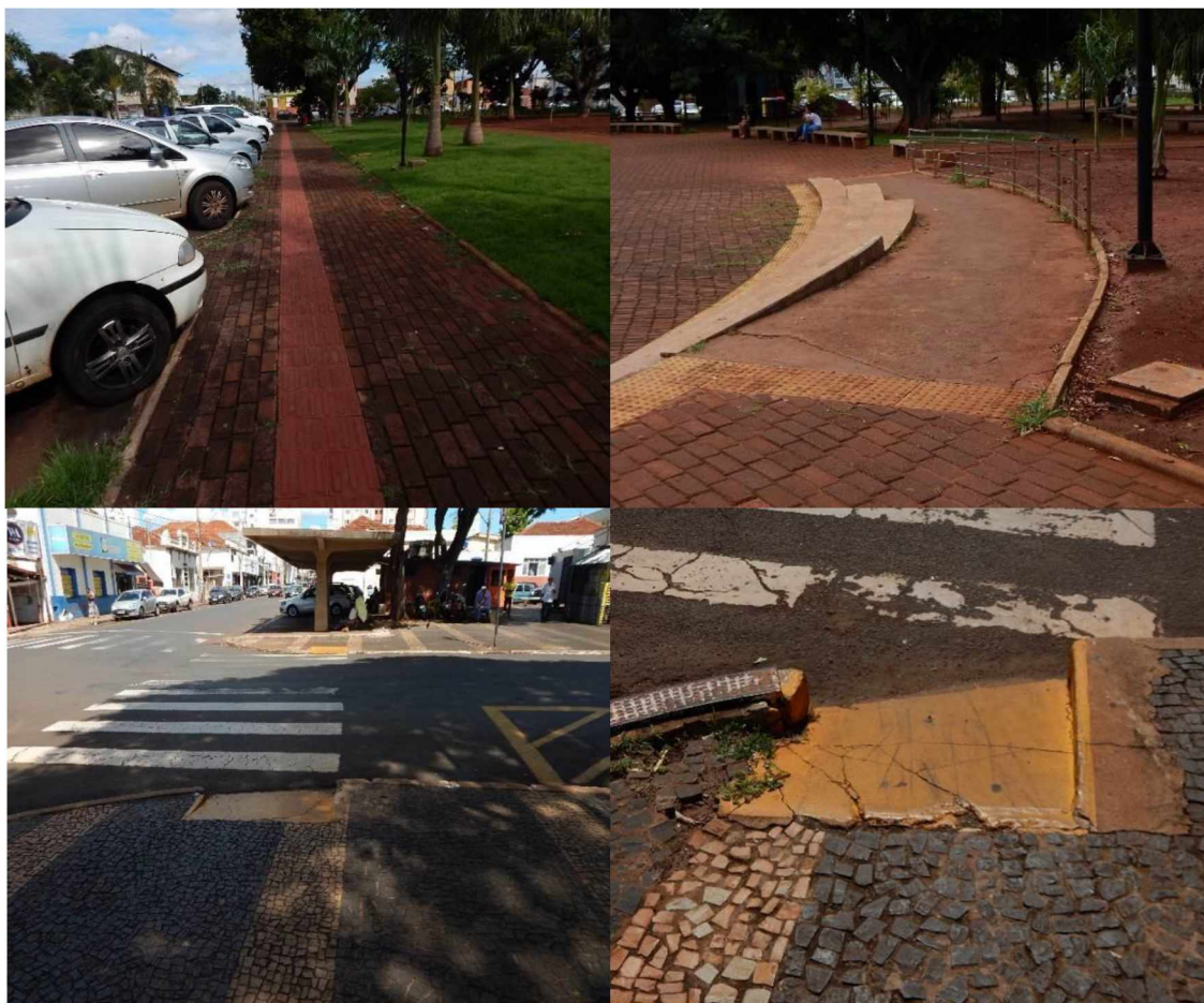
Figura 16- Rampas de acesso e piso tátil na Praça Getúlio Vargas; Rampa na Praça Conego Ângelo; Rampa na Praça Adelino Oliveira de Carvalho Fonte: PEREIRA, V.S. (2017).
