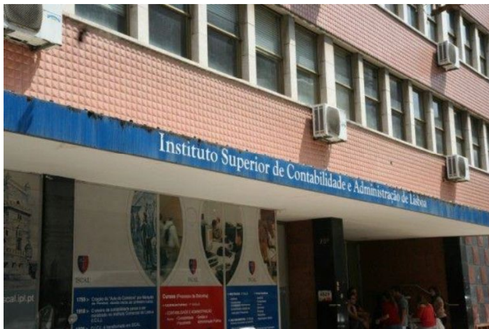
Figura 5 – Instalações atuais do ISCAL - Av. Miguel Bombarda
