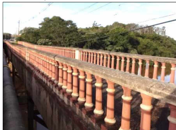
Figura 56: Três Corações - MG, Ponte dos Boiadeiros, 2017.
