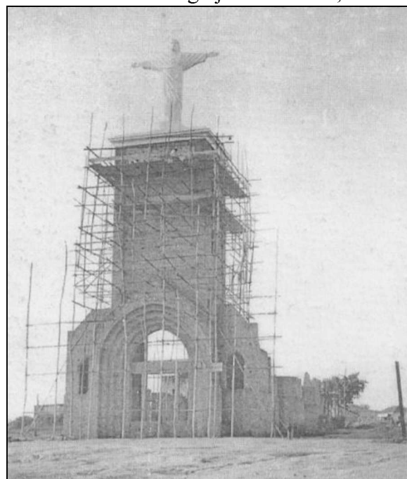
Figura 25: Três Corações - MG, instalação do Cristo Redentor na Igreja do Rosário, 1961.
