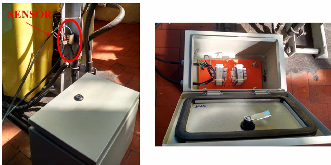
Figura 71 – Instalação do filtro sintonizado na PCH Martins.
