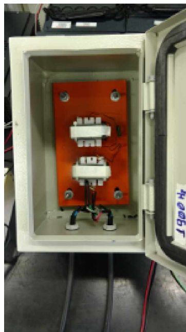
Figura 62 – Montagem do filtro sintonizado.
