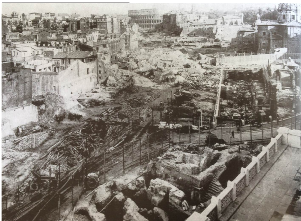
Figure 4. Demolition of the Velia Hill for the construction of Via dei Fori Imperiali, 1932. (Source: M. F. Boemi and C. M. Travaglino. 2006. Roma dall'alto: Exhibition Catalogue . Rome: Università degli studi Roma tre).
