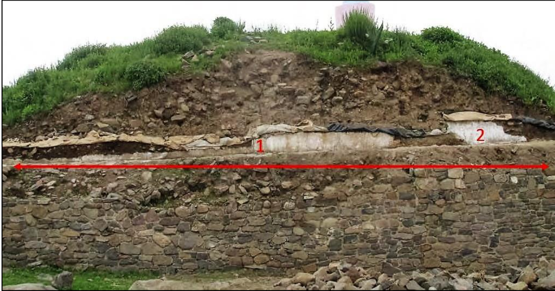
Imagen 15: Etapas constructivas de la Estructura 1 (1 y 2) y el descanso adyacente a esta. Fuente: De la Peña y Jaramillo, 2014.
