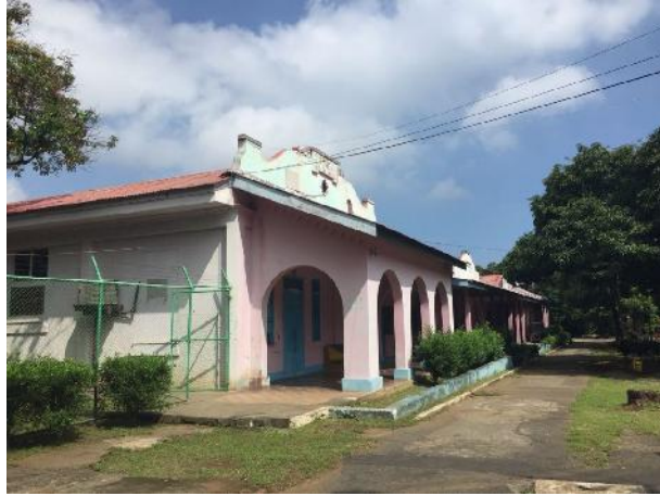
Imagen 4.14. Fachada Pabellones 3 y 4, Hospital Psicosocial
