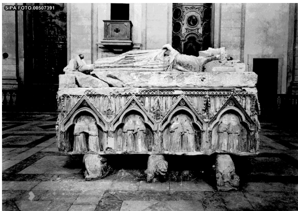
Fig. 3 – Colocação do túmulo do rei D. Diniz no centro da igreja de S. Dinis, Odivelas (de 1938 a 1961). Fotografia SIPA 00507391.
