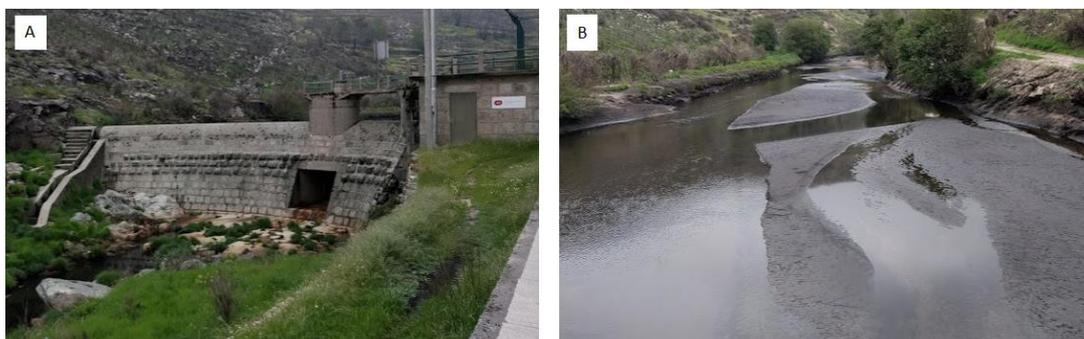
**Figura 12.5 – A: estrutura da barragem do Poço do Negro; B: Albufeira da barragem do Poço do Negro com materiais acumulados**
