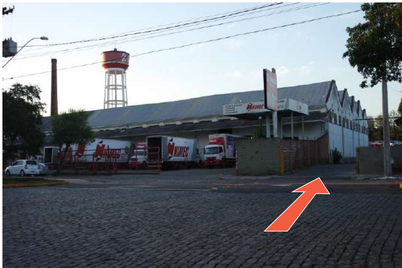
Figura 79 - Foto indicando a via interna e sua conexão com a Av.Acvat.
