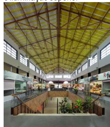
Figura 115 - Estrutura aparente e iluminação superior
