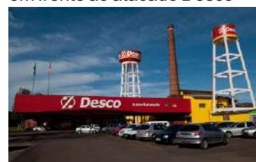
Figura 21 - Cobertura metálica em frente ao atacado Desco
