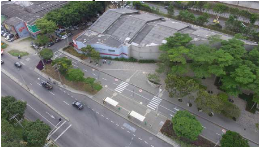
Figura 119 - Estrutura original do pavilhão ferroviário-
