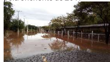
Figura 02 - Feira do produtor de Lajeado-Bairro Centro atingida pela enchente de 2017
