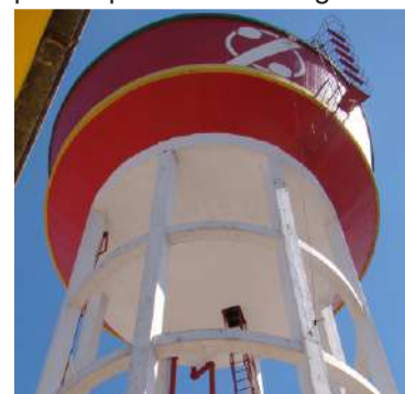
Figura 23 - Caixa d'água com pintura posterior não original
