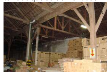
Figura 114 - Estruturas do telhado que serão mantidas
