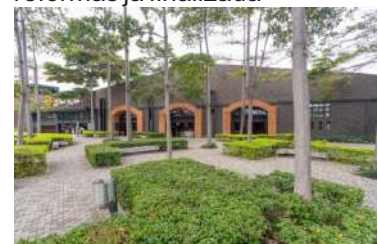
Figura 122 - Edificação após as reformas já finalizada
