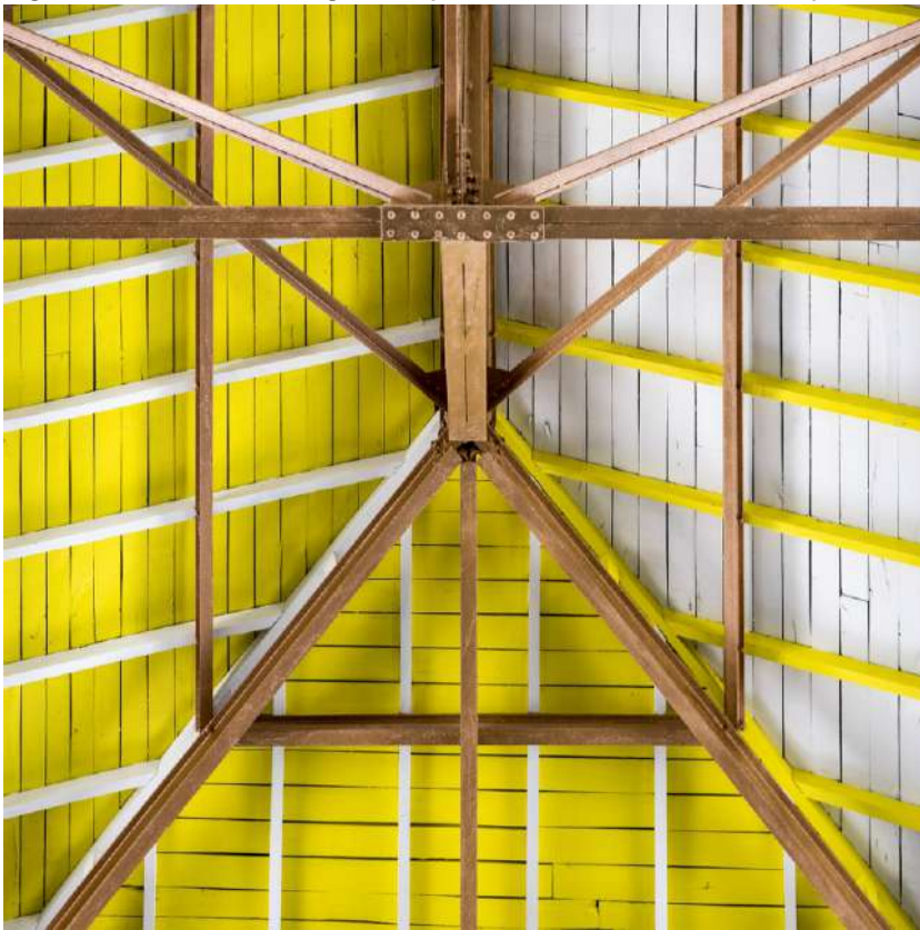
Figura 118 - Estrutura original do pavilhão ressaltada através a pintura
