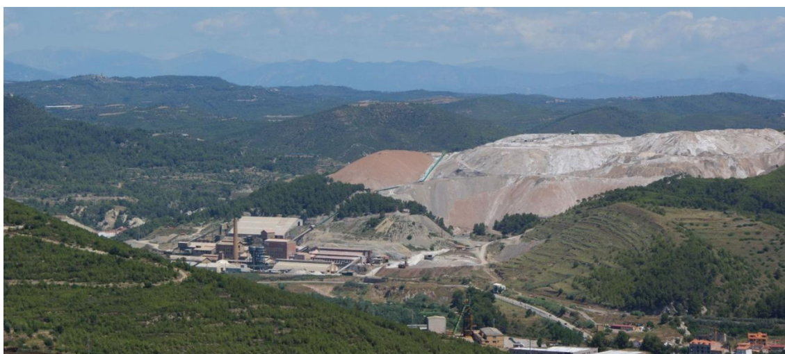
Figura 2.12. Aspecte actual dels runams salins de Súria, es pot observar també la fàbrica i el nucli de l'empresa Iberpotash, S.A.
