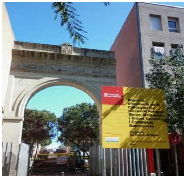
Rehabilitación de Plazas-zona de la Maquinista
