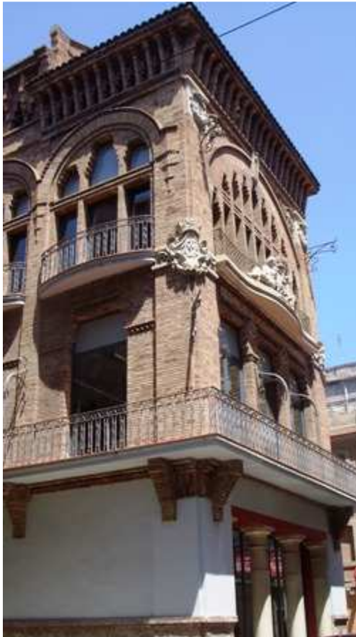
Local de la Cooperativa La Fraternitat, alberga actualmente la Biblioteca de la Barceloneta
