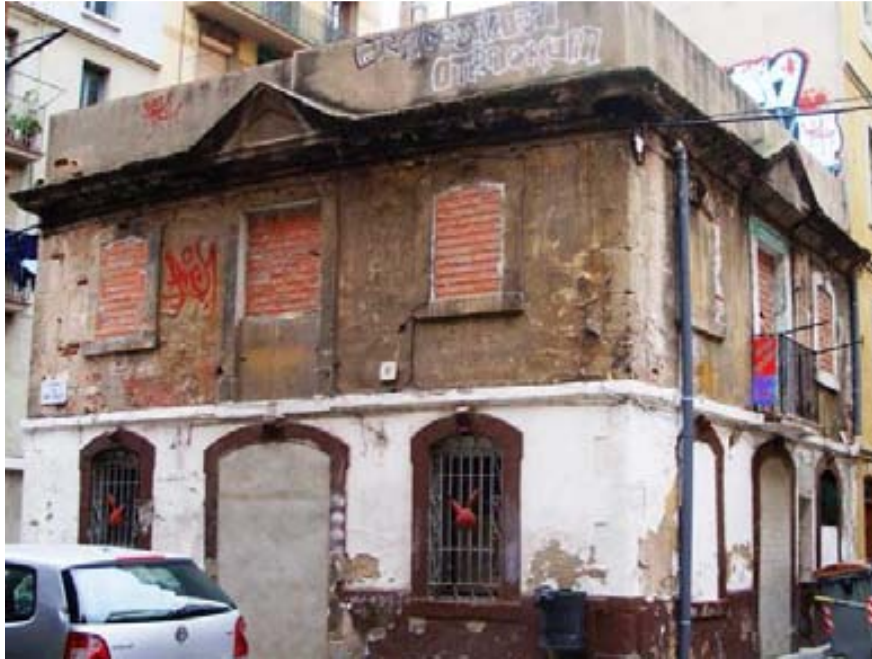
Fotografía correspondiente a la Casa del Porró antes de su rehabilitación
