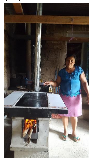
Foto 1. Instalación de estufas ahorradoras de leña con familias ECA La Prensa, TeSAC Olopa. Julio 2008
