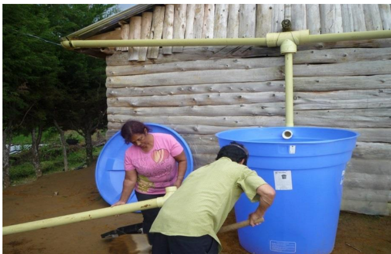
Figura 19. Foto de la construcción cosecha de aguas lluvia, como medida de adaptación priorizada en Cauca. Fuente: Ecohábitats /CCAFS
