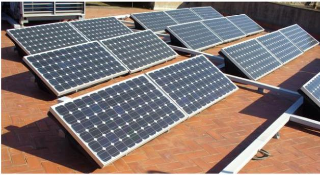
Fig. 3. Campo fotovoltaico de 3,1 kWp en la extinta EUETIB.
