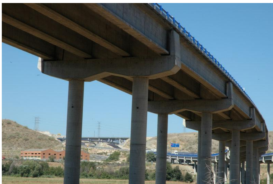
Figura 28. Viaducto de vigas prefabricadas, AVE Madrid-Barcelona sobre Rio Jarama.
