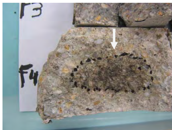
Figure 2.40 : Évaluation de la profondeur de pénétration des ions chlorures dans le béton F4 par pulvérisation de nitrate d'argent.
