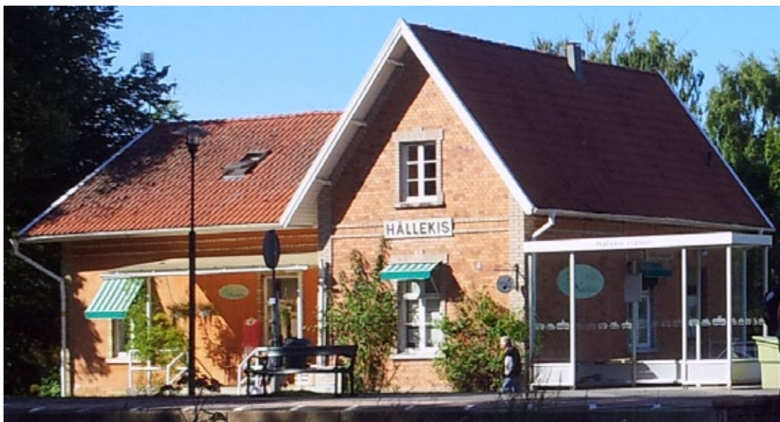
Stationshuset i Hällekis sett från andra sidan tågspåret med perrongen i förgrunden.
