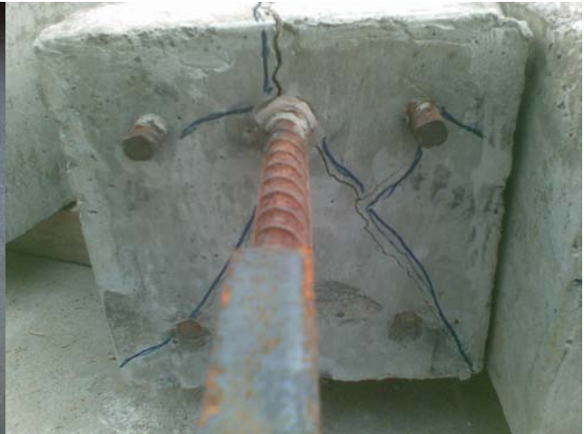
Fig. 3 (b) : OPC concrete specimen
