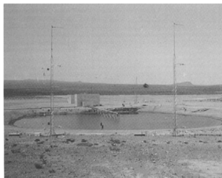
直径 58m 水池
