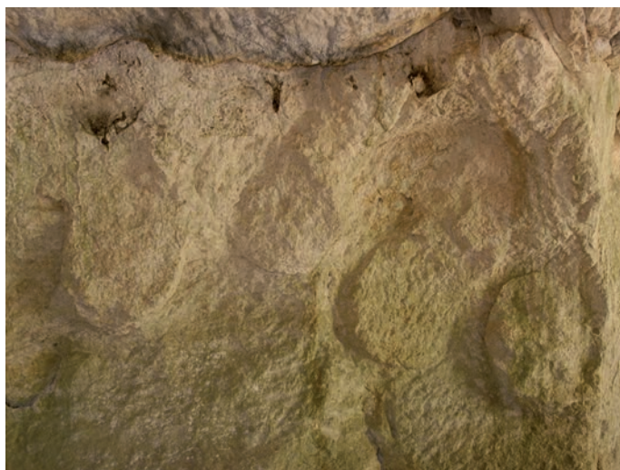
Fig. 7 – Cylindres de meules creusés en délit (grande cavité au sud de la zone III) (cliché : F. Tésorio).
