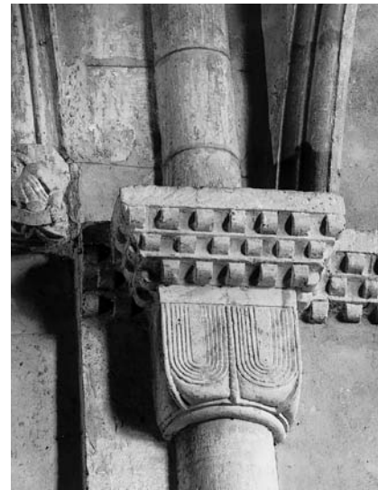
Détail d'un chapiteau et d'une frise de billettes du XII e siècle (1 ère travée du chœur, côté nord).
