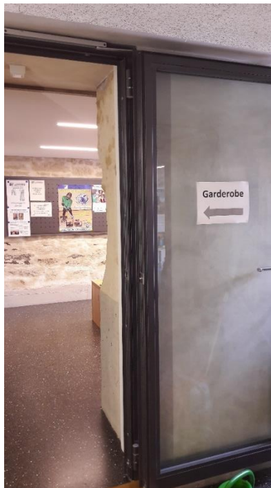
Abb. 59: Provisorische Beschilderung der Garderobe im Erdgeschoss
