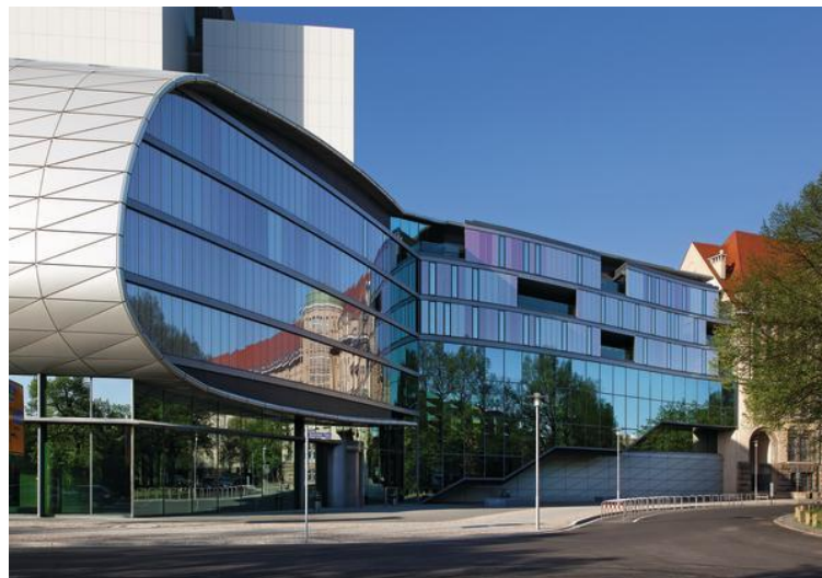
Abb. 6: Die Außenfassade des Erweiterungsbau der Deutschen Nationalbibliothek 62
