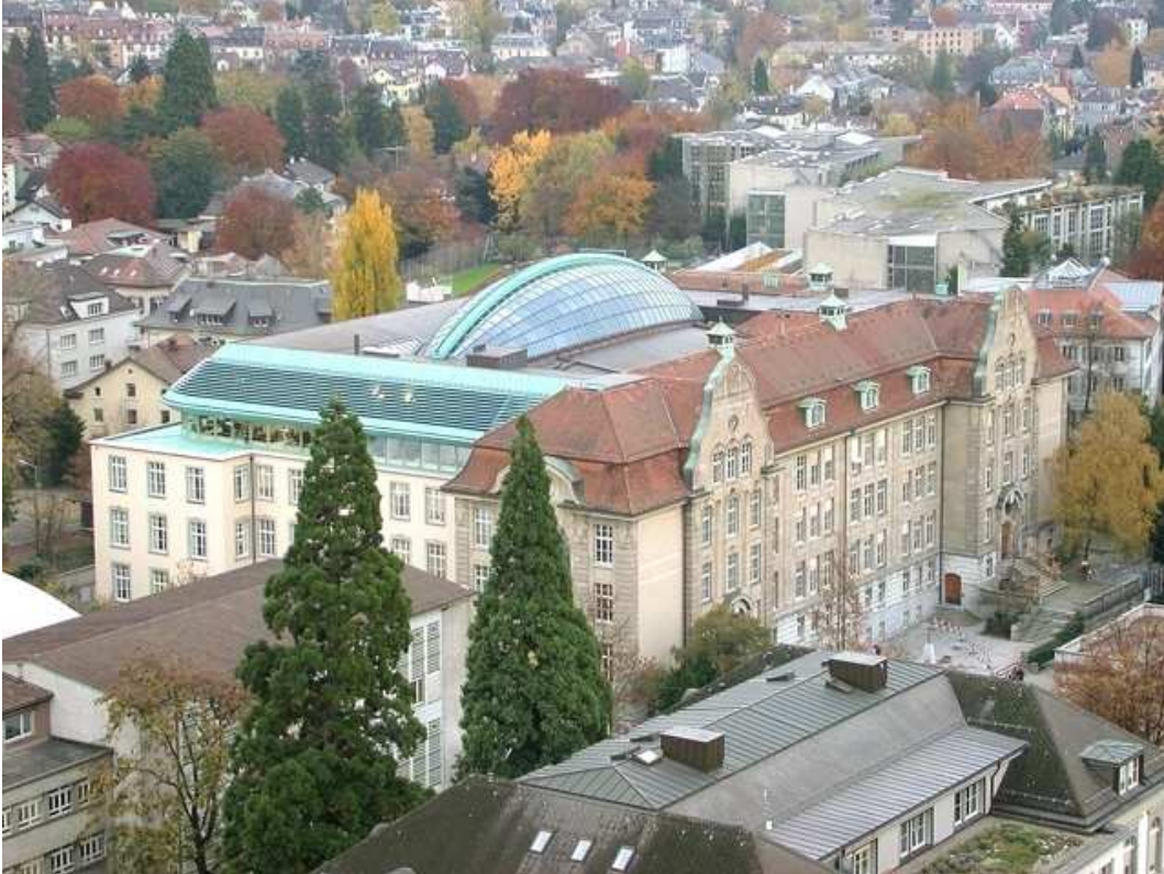
Abbildung 15 Sicht auf das Gebäude der Bibliothek. Oben ist der Einbau gut zu erkennen.
