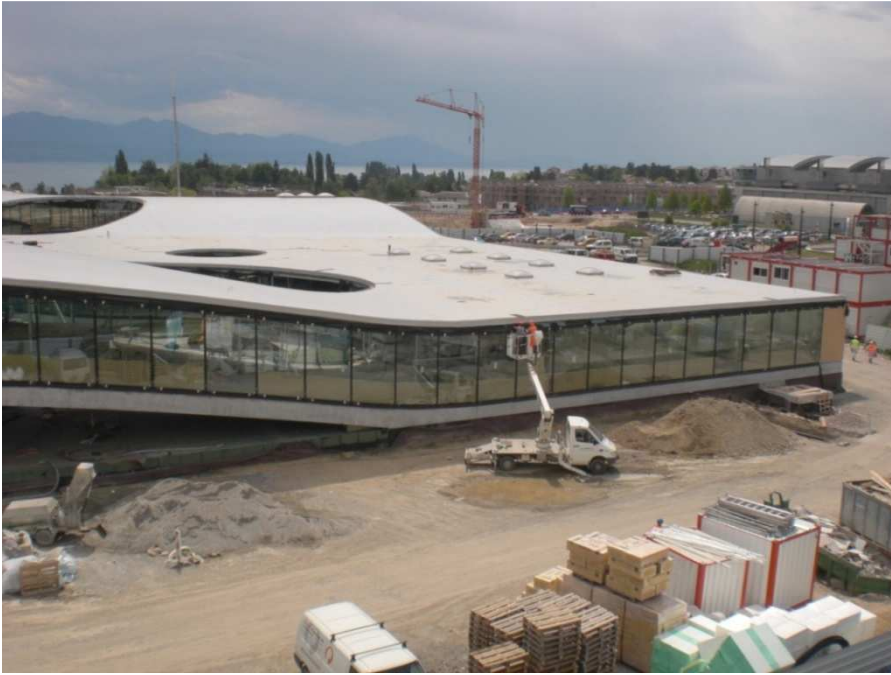
Abbildung 4 Teilansicht der Baustelle des RLC am 08.05.2009 Quelle: eigenes Foto
