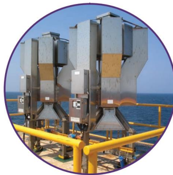
Figure 1-19 : Thermogénérateur (1000 Watt) en mer au Gabon 53 .
