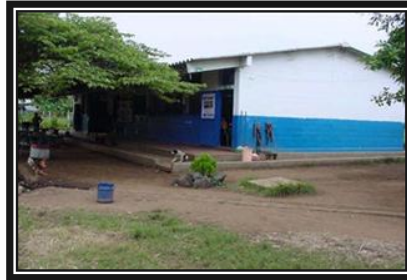
Centro escolares en la zona rural
