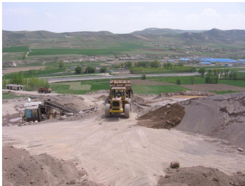
شکل ۷۱. کارگاه ماسه شویی مجاور رودخانه یامچی اردبیل
