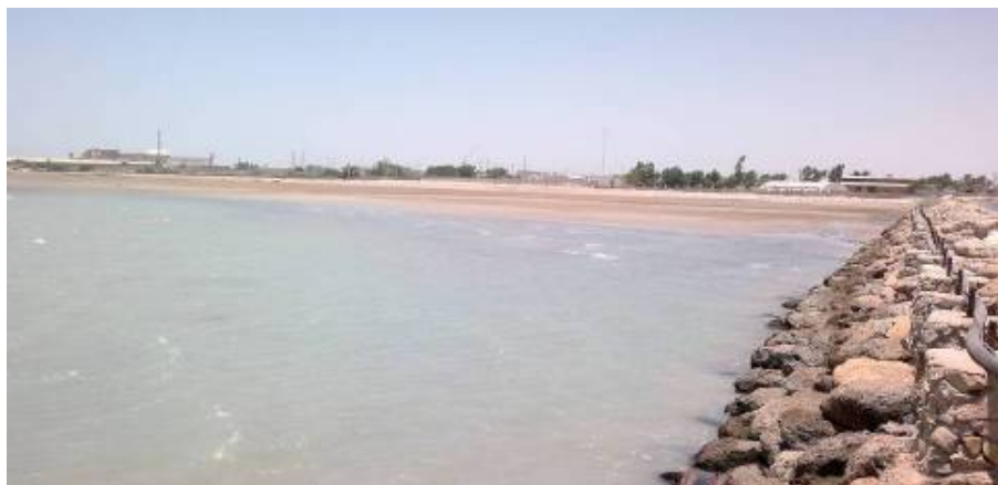
شکل شماره ۶- نمایی از ایستگاه تحقیقاتی بندرگاه و محل آگیری از دریا
