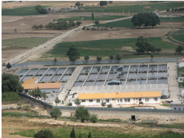
تصویر ۲-۱: نمای محل اجرای پروژه
